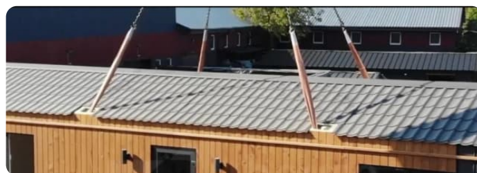
Levage d'un module à la grue : par le haut avec un châssis acier, par sangles autour du caisson pour une ossature bois seule.
