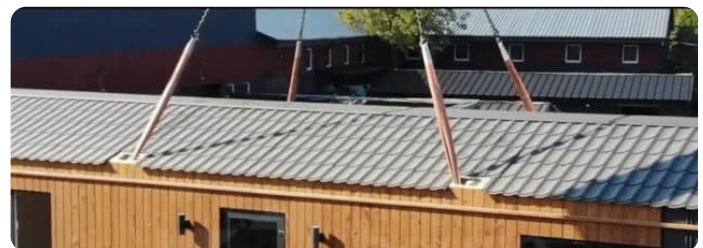
Levage d'un module à la grue : par le haut avec un châssis acier, par sangles autour du caisson pour une ossature bois seule.
